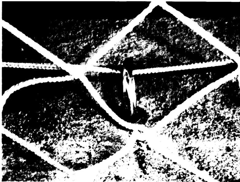
*Visualização de um dos ganchos para fixação da rede na alvenaria*
